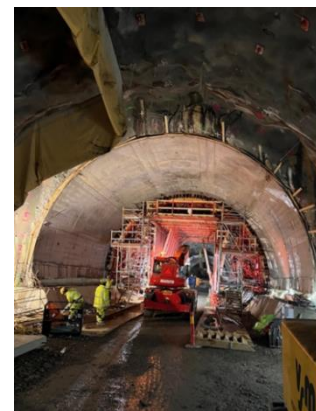
Mälarpassagen, gjutning av avjämningsbetong
