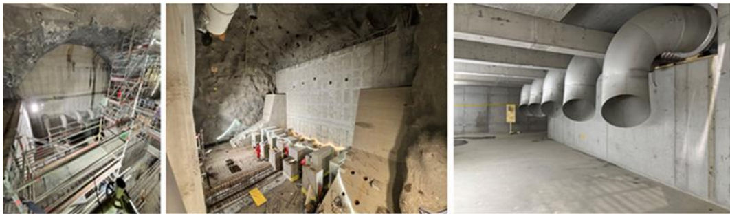
Sickla januari 2026. Från vänster till höger: Bromma PST pumpgröp / pumpsal / utloppsör i grovreningen
